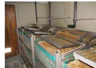
Abscheidung der Feststoffe mit Zierler Presse und spätere Entsorgung im Tal
