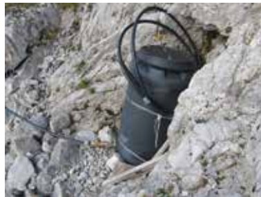
Quelfassung 1 am Großen Hundstod Wasserleitungslänge zum Ingolstädter Haus ca. 1,2 km
