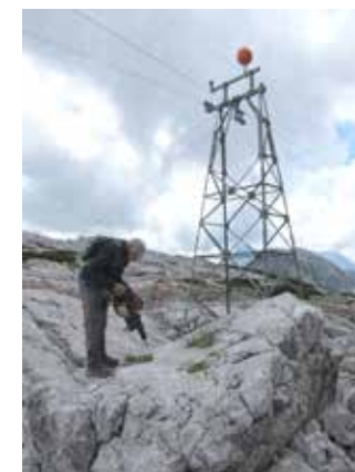
An MSB Stütze 5 mussten von Erich Fuchs neue Anker gebohrt werden.
