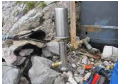
Quelfassung 1 am Großen Hundstod. Einbau einer hydraulischen Wasserstandregulierung.
