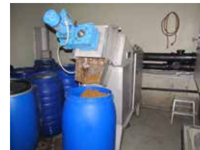
Abscheidung der Feststoffe mit Zierler Presse und spätere Entsorgung im Tal
