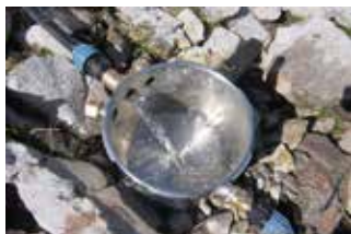
Ein Dampfkochtopf wurde als Sammelbehälter für unsere einzelnen Wasserleitungen umgebaut.
