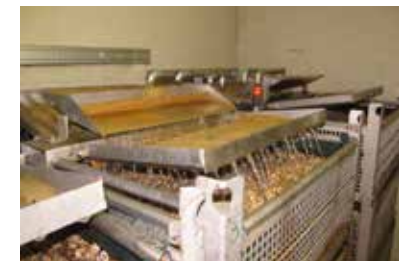
Tropfkörperanlage: 32 Schotterkörbe sind verschlamm und müssen am Anfang der Saison 2026 neu befüllt werden.
